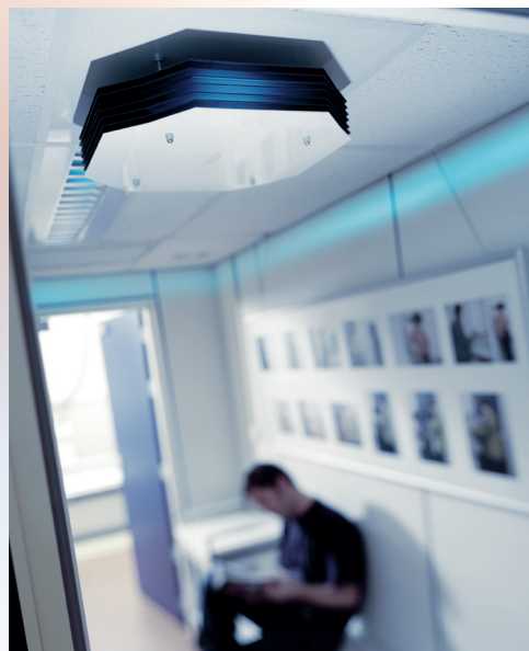
Modulo di sanificazione UVC Upper-Air di Signify / Upper-Air UVC sanitisation module from Signify
